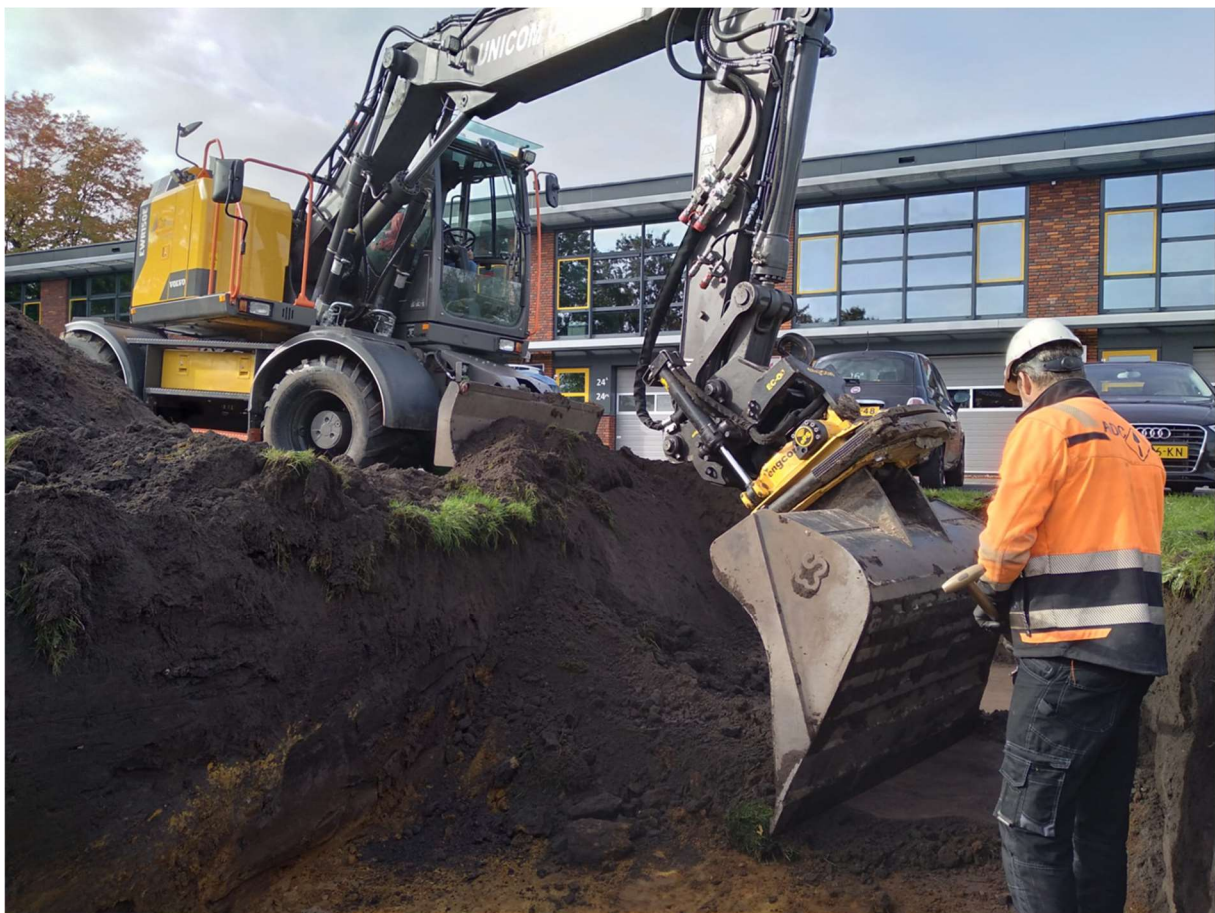
Het uitdiepen van een proefsleuf.
