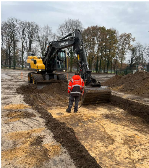
Het uitdiepen/aanleggen van proefsleuf 2
